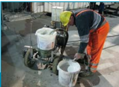
Beispiel eines Kolben-Airlessgeräts im Einsatz
