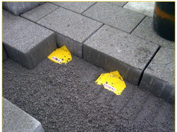
Optimale Platzierung der Anker im Läuferverband
